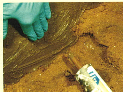
Bei der Beschichtung der Seitenscheiben mit braunen Silikon sind unbedingt Einweghandschuhe zu tragen. In das Silikon können verschiedene Materialien gedrückt werden.
