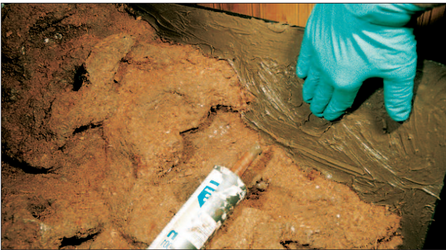
Beim Beschichten mit Silikon sollte man unbedingt Einweghandschuhe tragen.
